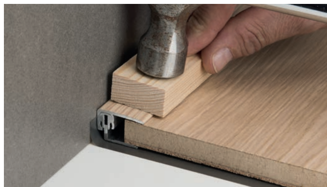
Instalace ukončovacího profilu hliníkového
