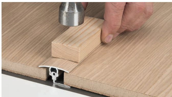
Instalace přechodového profilu hliníkového
